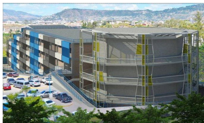
Edificio C-3 que albergará a la carrera de Arquitectura en la UNAH.
